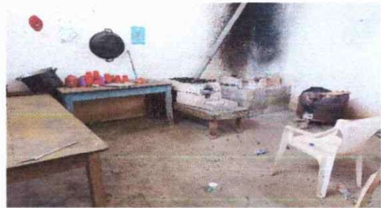
Foto 4: reparacion de polleton de cocina
